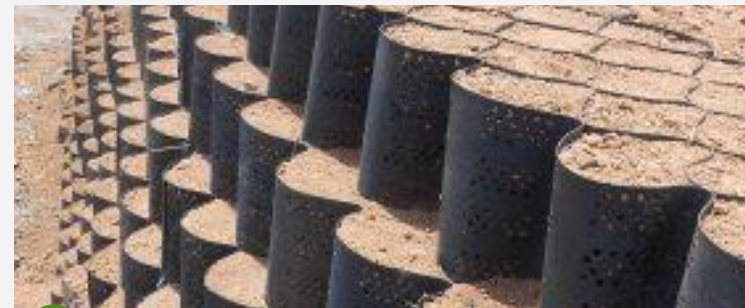
3 Camadas de StrataWeb™ preenchidas e compactadas.
