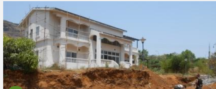
1 Situação inicial da obra.
